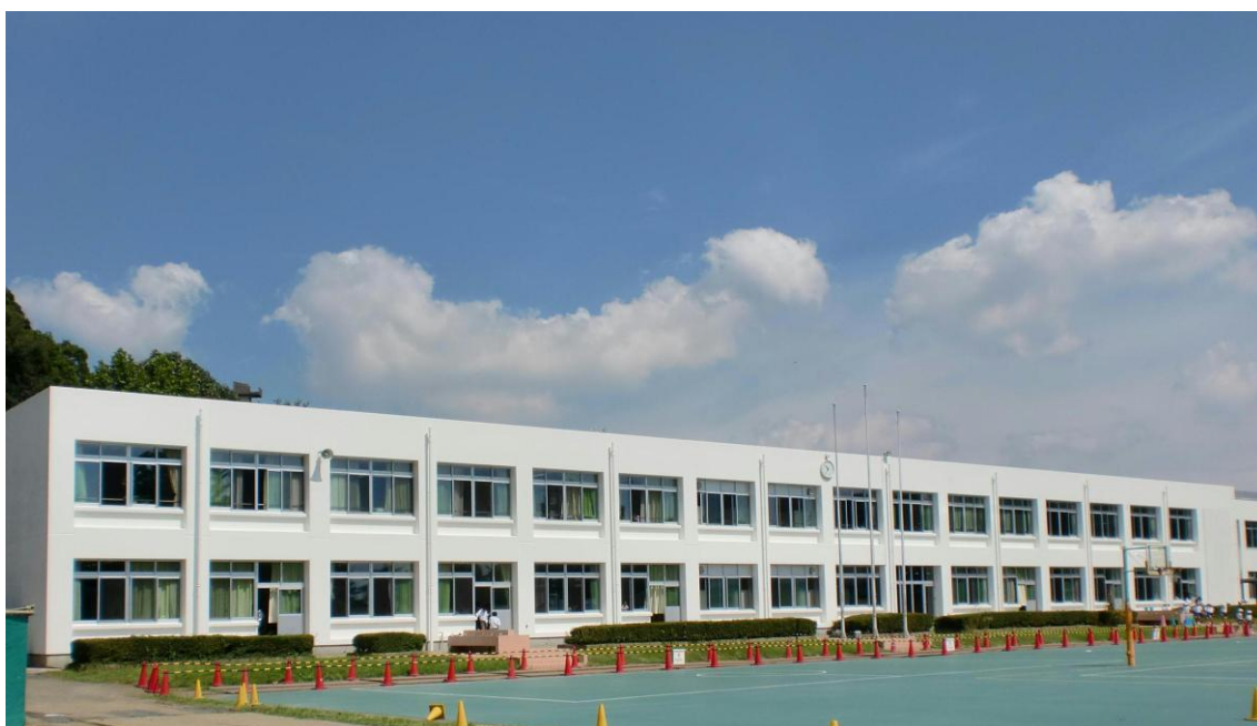
改修の終わった教育学部附属小学校の「中高学年棟」
