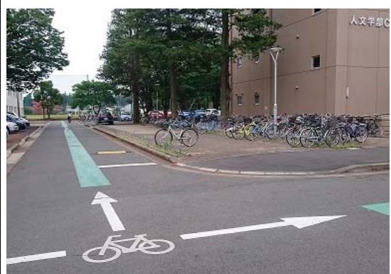
■自転車通行可能道路の整備 (人文学部 C 棟裏)
