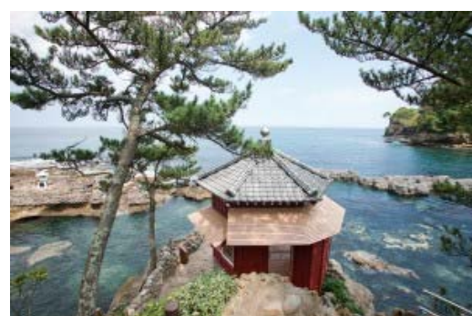
■再建した六角堂
