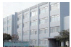
改修された理学部G棟
