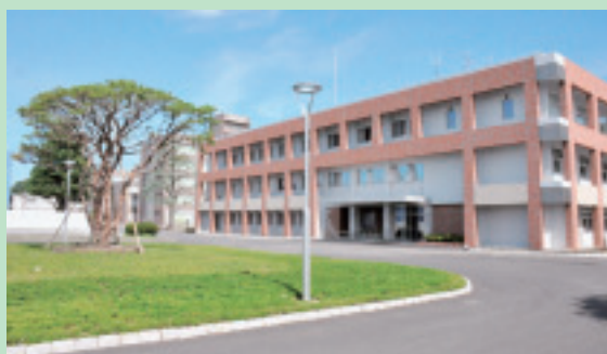
耐震改修を終えた事務局管理棟
