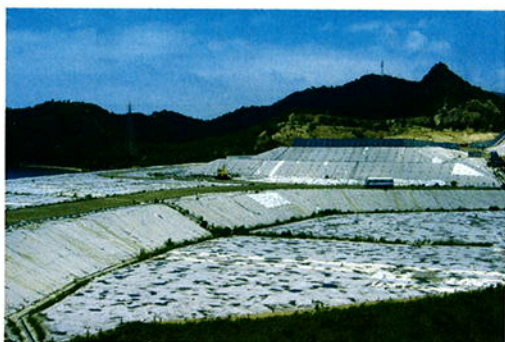
広大な豊島(香川県)の産廃不法投棄の処理現場(ダイオキシンを含んだ埃が舞い上がるのでシートをかけている。)
